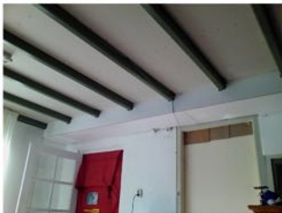
Luchtlekkage langs de balkkoppen
