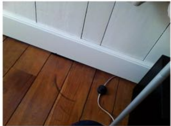
Koude lucht uit de wand / onder de vloer komt onder de plint vandaan, de vloer zelf lijkt aardig dicht.
