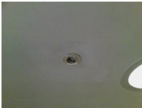
De aftimmering in de garderobe heeft op een of andere manier open verbindingen met de buitenlucht / zolder
